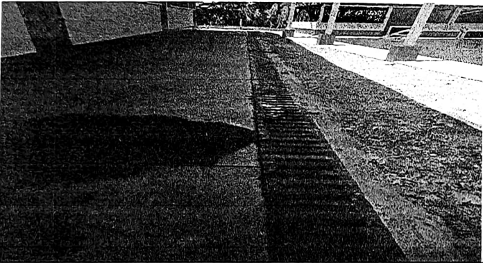
Foto 3: Instalación de rejía en cuneta de concreto
