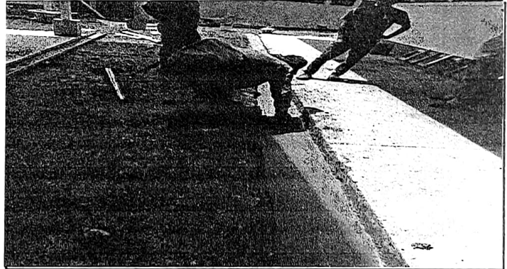
Foto 4: Realización de cuneta de concreto
